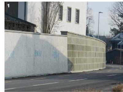
1 Übergang von der Schlossmauer (mit Kalkputz) zur Kirchenmauer (mit Sandstein-Verblendung).
