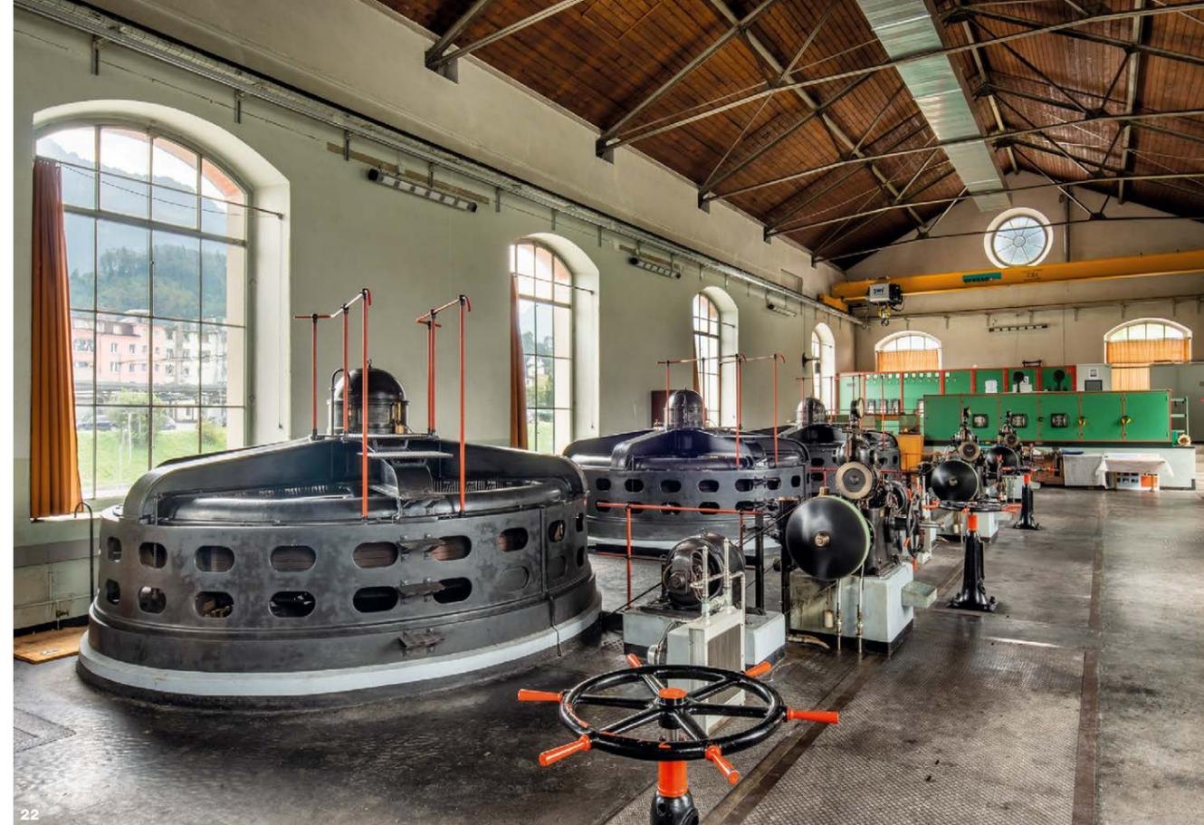
19+20 Le régulateur des turbines et le pupitre de commande de l'installation originale de 1894.
