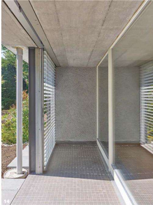
**14+15** Energetische Ertüchtigung: Dank des Einbaus einer Zweifach-Isolierverglasung gelang der Erhalt der Fensterrahmen.
