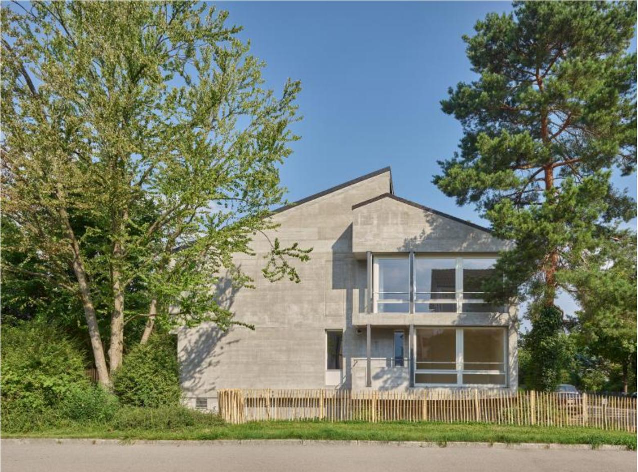
Ansicht von der Hohmadstrasse: Die Erscheinung des Gebäudes blieb trotz der Betonsanierung und dem Einbau einer Indach-PV-Anlage unverändert. (Foto: Carolina Piasecki)
